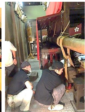
布袋車の点検修理
