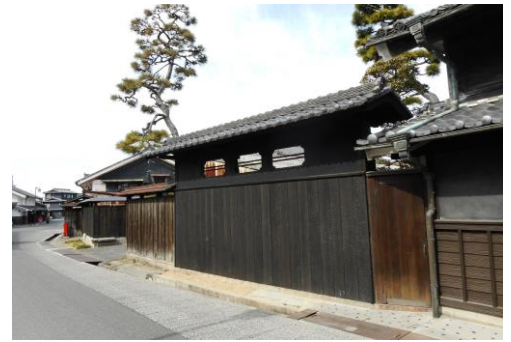
修復なった鉦目板塀
