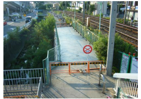
コンクリート舗装された駐輪場
