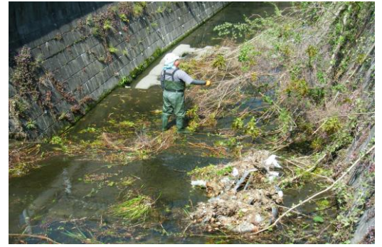
藍染川（手越川）の清掃作業
