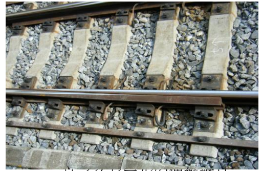
ロングレールの伸縮継目
